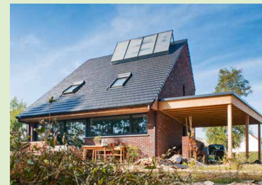
Het grote zuidgerichte dak leende zich uitstekend tot de plaatsing van een zonneboiler. Deze is aangesloten op een groot buffervat in de wasplaats, dat instaat voor de verwarming van het sanitaire water en het aansturen van de vloerverwarming.
